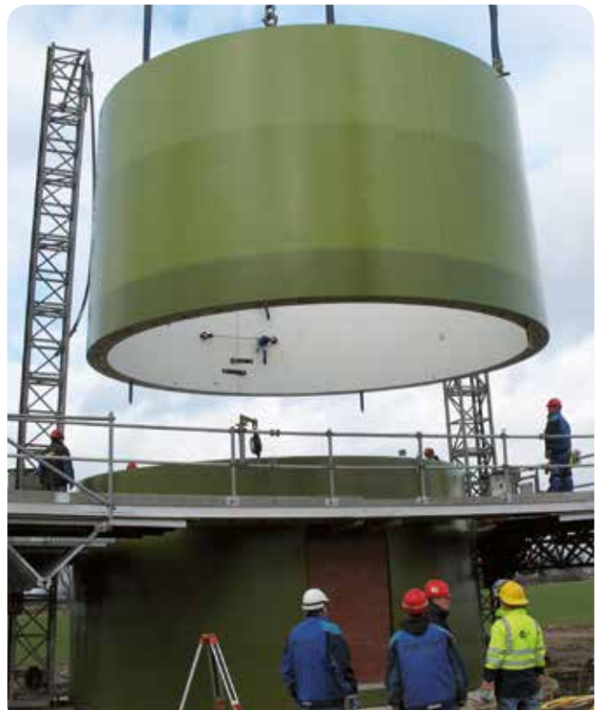
Montage von Windkraftanlagen
