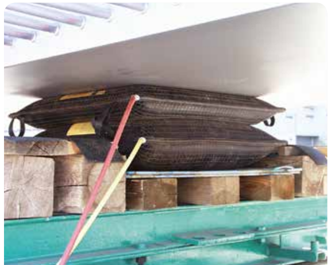
Unterbau von Brückenelementen
